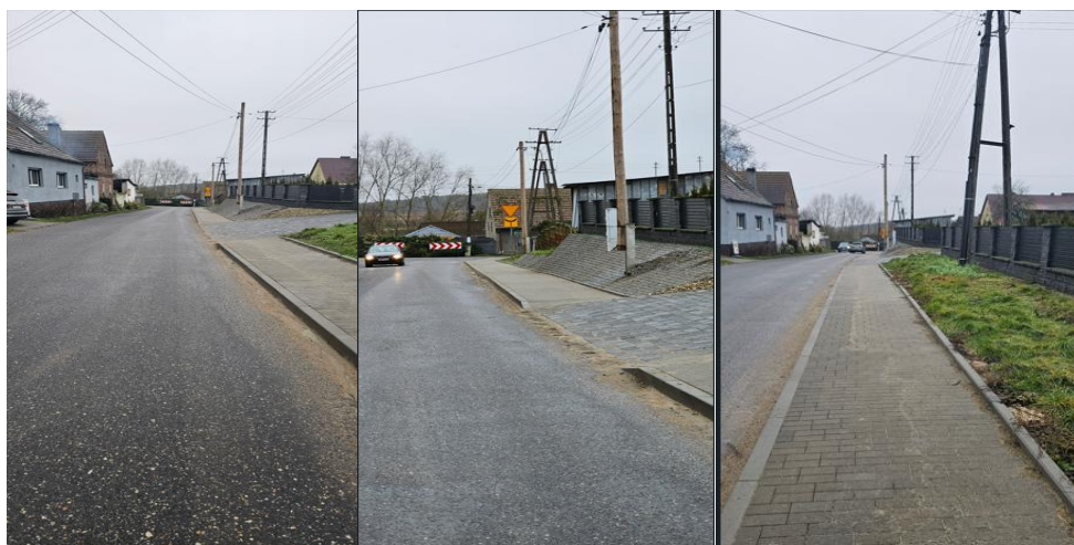
Fot. Budowa chodnika w m. Lisów.
