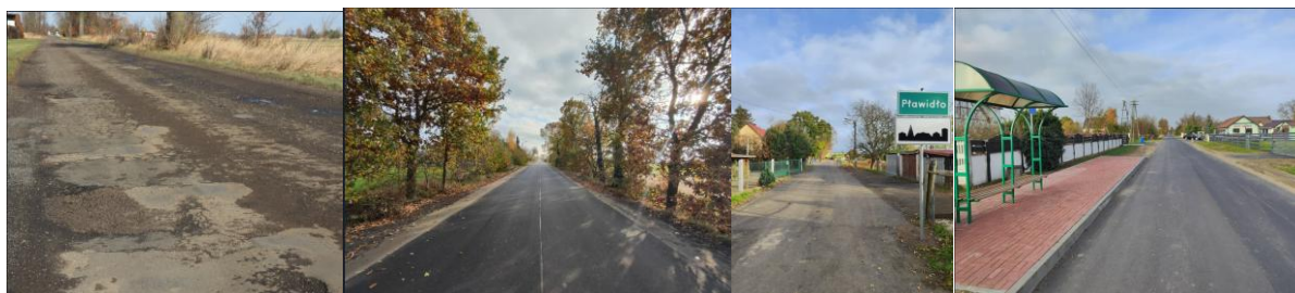
Fot. Remontowany odcinek drogi w m. Pławidło – przed i po remoncie.
