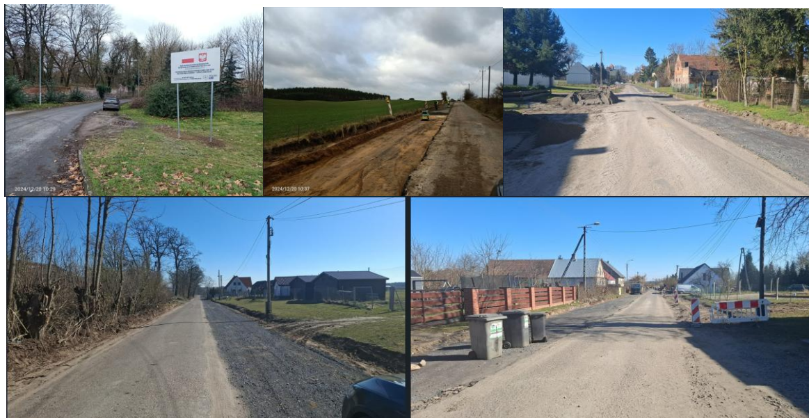
Fot. Droga powiatowa na odcinku Siemno-Ośno Lubuskie – w trakcie robót budowlanych.
