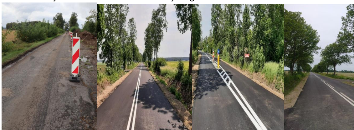
Fot. Remontowany odcinek drogi Cybinka – Kłopot - przed i po remoncie.
