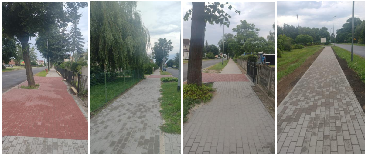
Fot. Remontowany chodnik – ul Dąbrowskiego w Cybinie - stan po remoncie.
