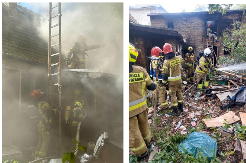
Fot. 6. Pożar domu jednorodzinnego i gospodarczego - Słubice ul. Szczecińska
